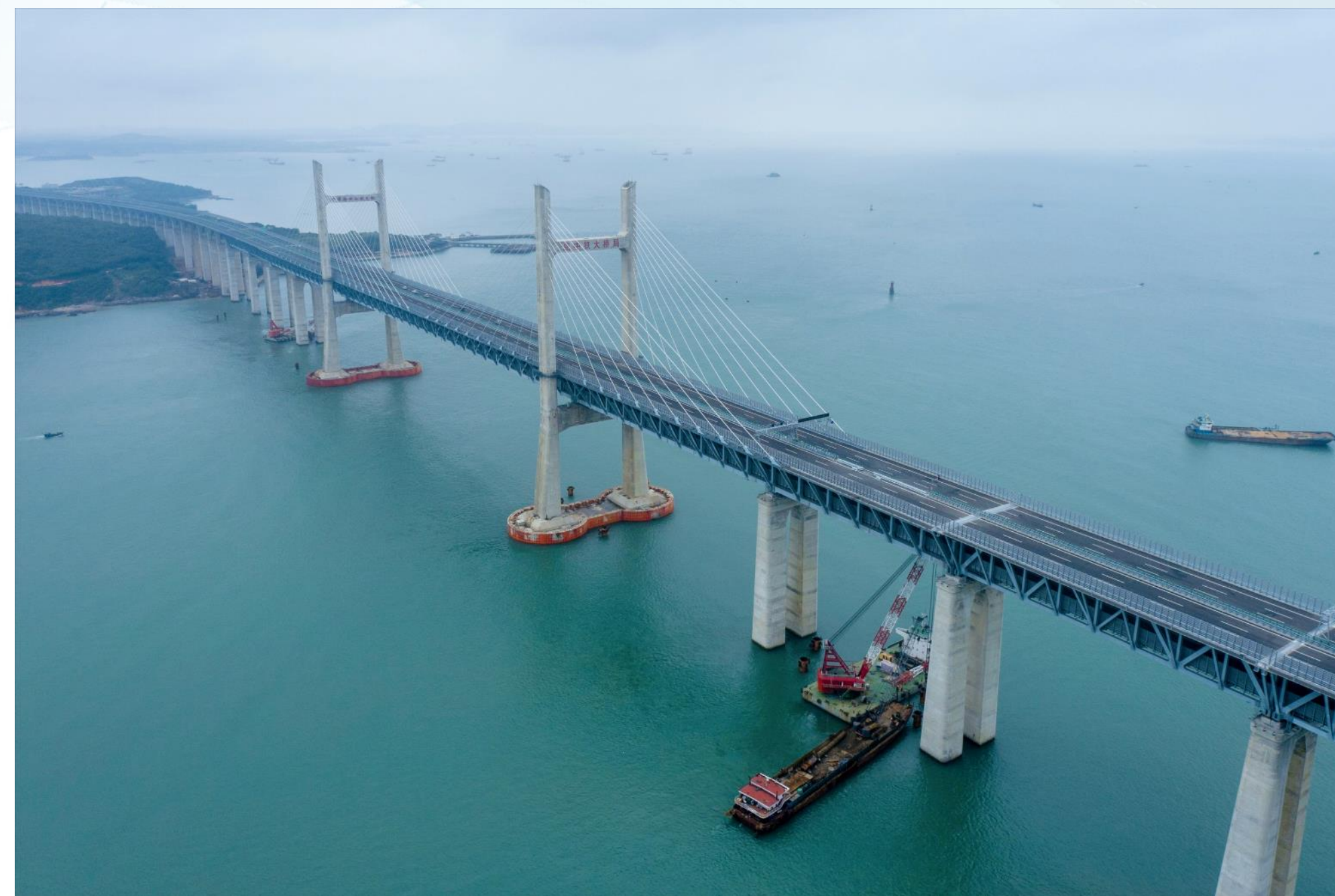
平潭海峡公铁两用桥 跨海双塔双索面斜拉桥，是我国第一座真正意义上的公铁两用跨海大桥，实现了在“建桥禁区”建桥。
