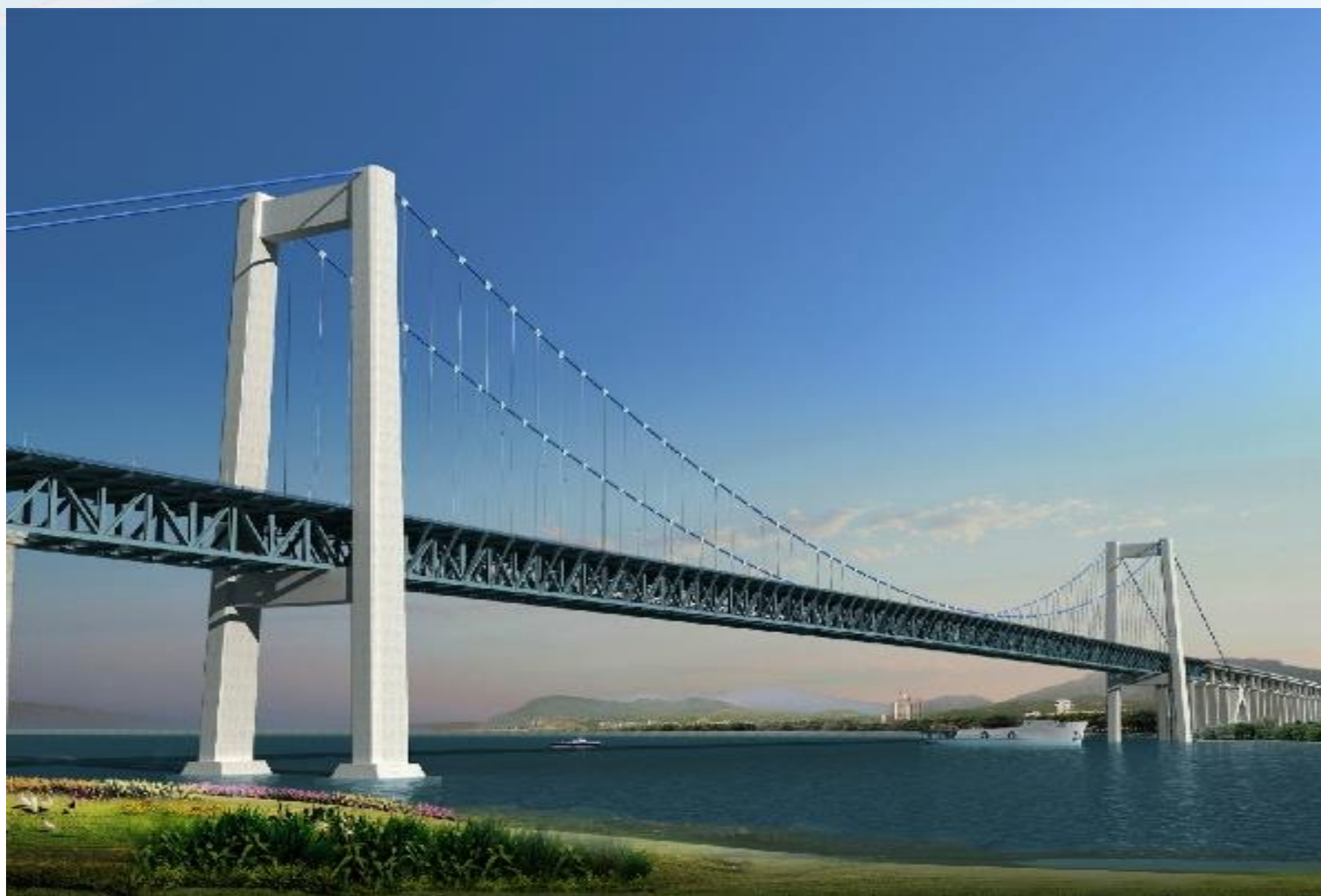
五峰山长江大桥 设计时速250公里，是世界首座高速铁路悬索桥。
