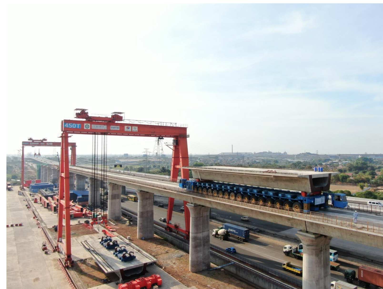
雅万高铁施工现场
