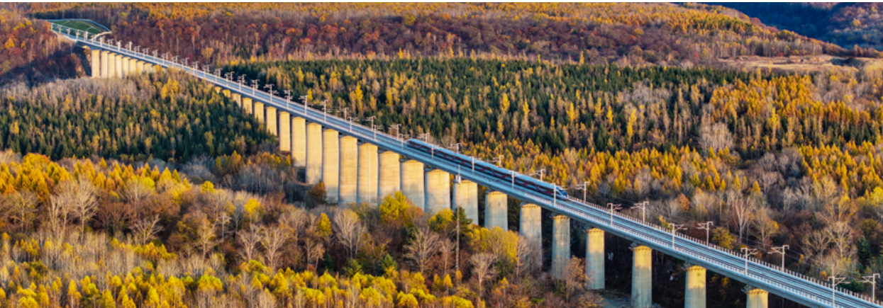
沈佳高铁沈白段建成开通
