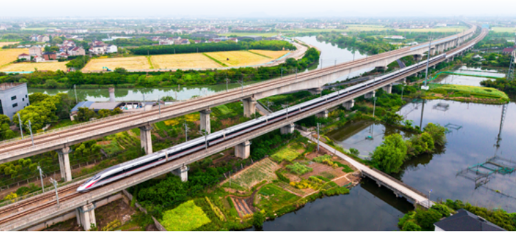
动车组列车行驶在宁杭高铁上
