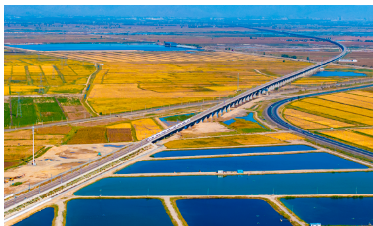
包头至银川高铁实现全线贯通运营
