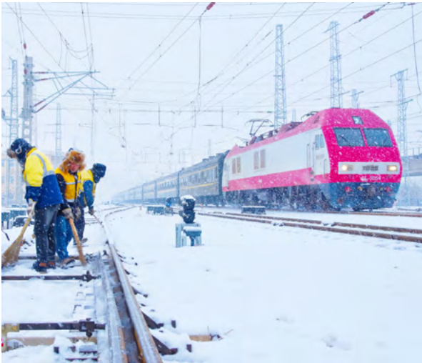
启动应急响应，开展除冰除雪作业
