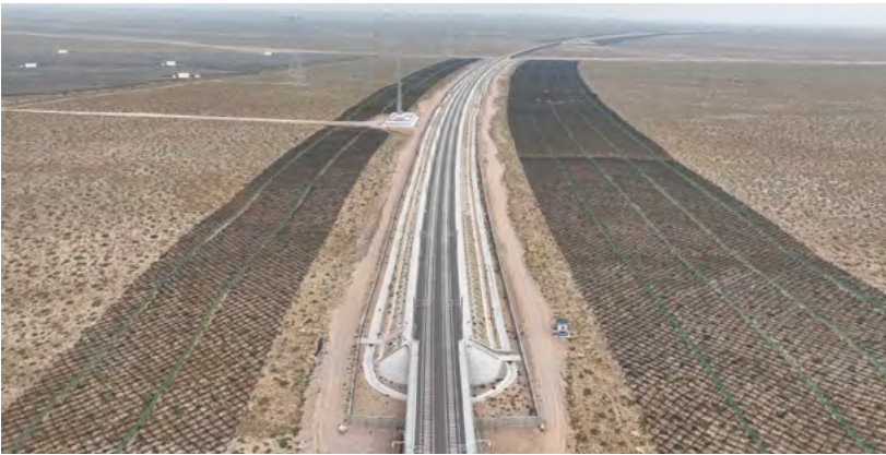
铁路线路两侧设置工程防沙带
