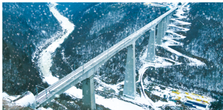
沈白高铁头道松花江特大桥
