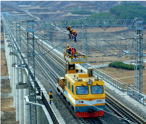
开展接触网设备检修
