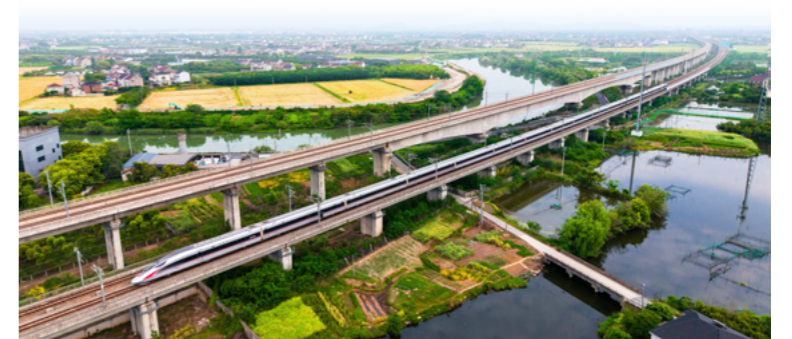
动车组列车行驶在宁杭高铁上
